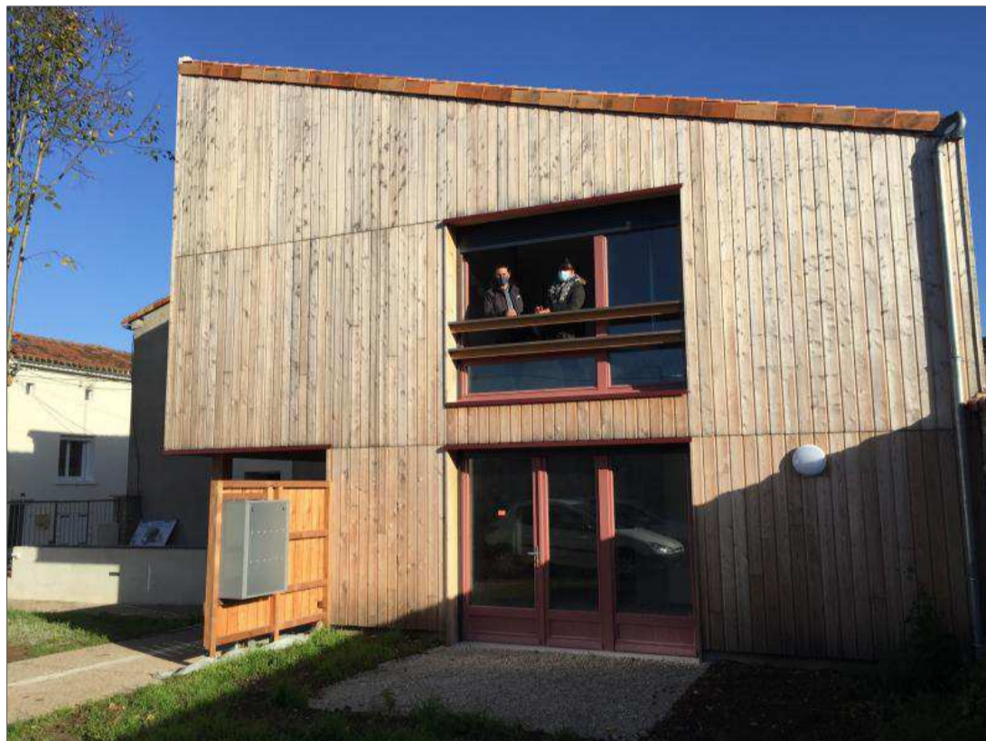
Une extension en ossature bois a été réalisée pour créer deux logements dans le prolongement de l'ancienne maison des religieuses, totalement transformée.
