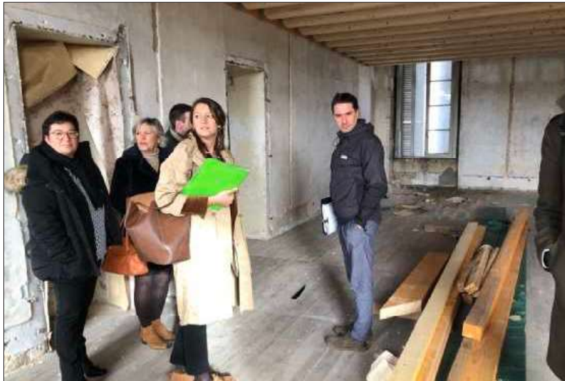
L'ancienne maison de maître de 500 m 2 , au 32 de la Grand-Rue, abîmée, a été mise à nu pour y aménager six logements. Photo CL
